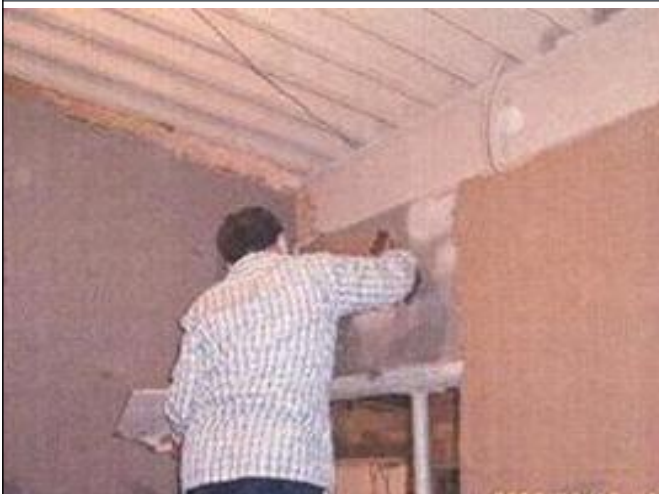
벽면 황토미장재 시공
