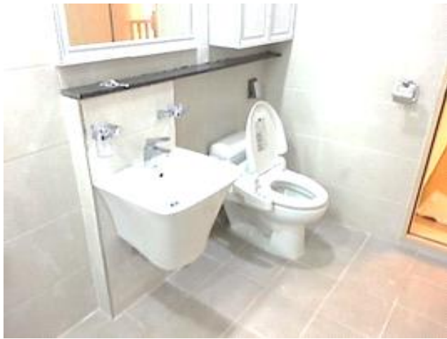
화장실 벽, 바닥
